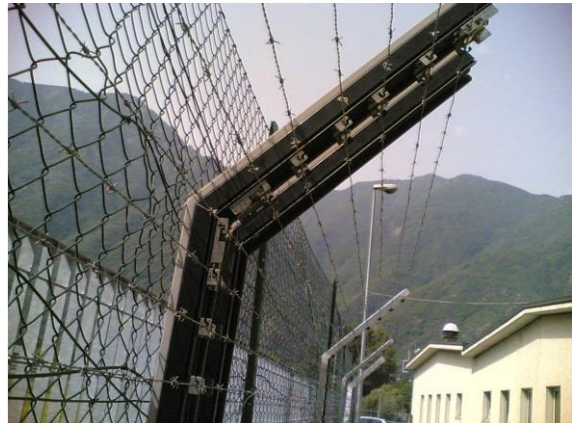
Opengewerkte Sensorpaal voorzien van anti-overklim
