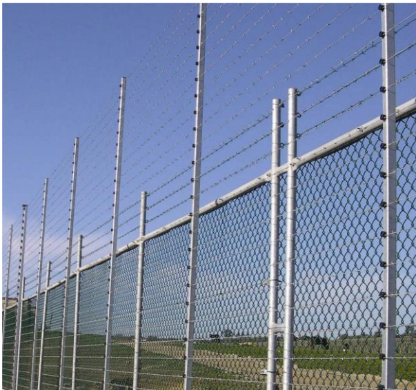
Bestaand hekwerk voorzien van extra TPS
